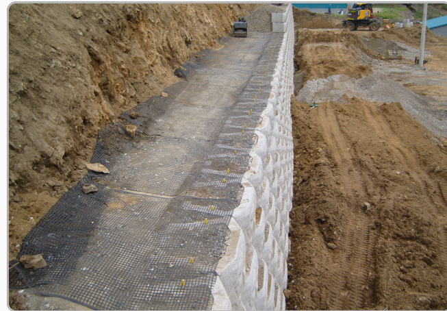
4. 뒷채움 골재 다짐 & 그리드 설치
