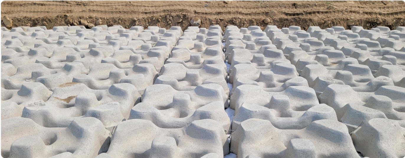
왕숙천 수해상습지 개선사업공사
