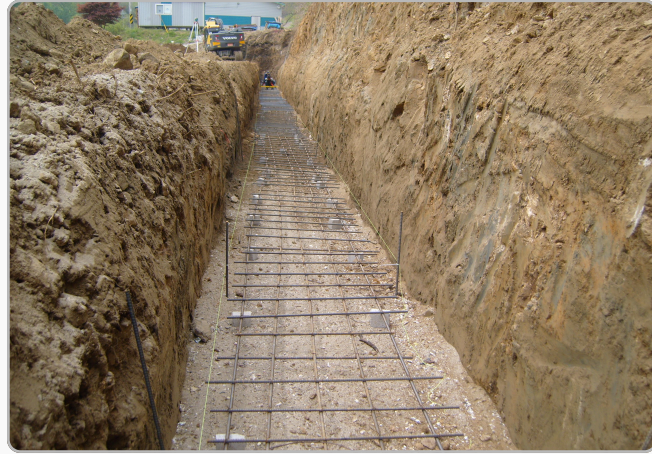
1. 기초 터파기 & 철근 배근
