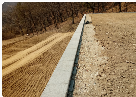
8. 마감 블록 설치
