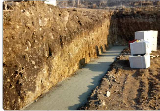
2. 기초 콘크리트 (레미콘 타설)
