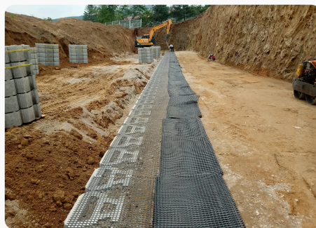
5. 다짐 및 그리드 설치
