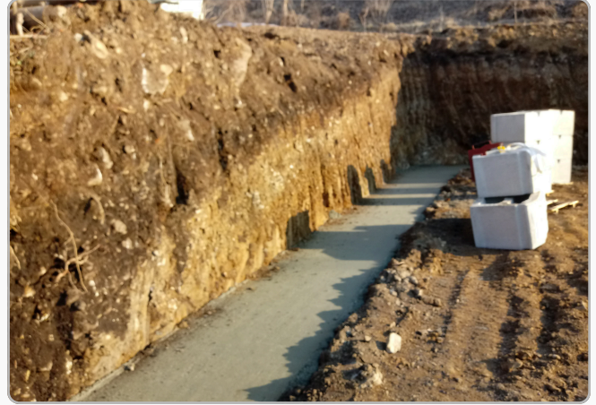
2. 기초 콘크리트 (레미콘 타설)
