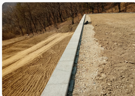
8. 마감 블록 설치
