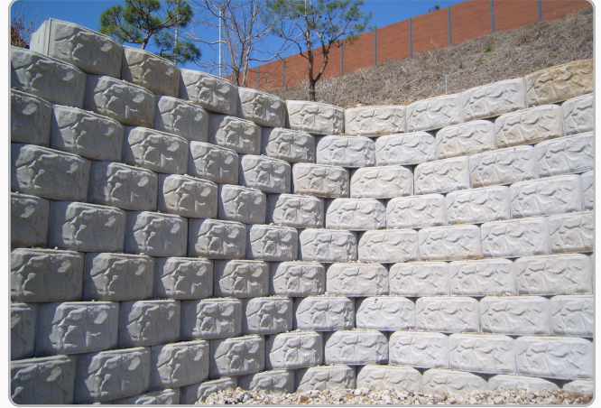
• 가평군 상면 임초리 옹벽공사
