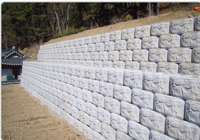
• 양평군 옥천면 용천리 절토사면 옹벽공사
