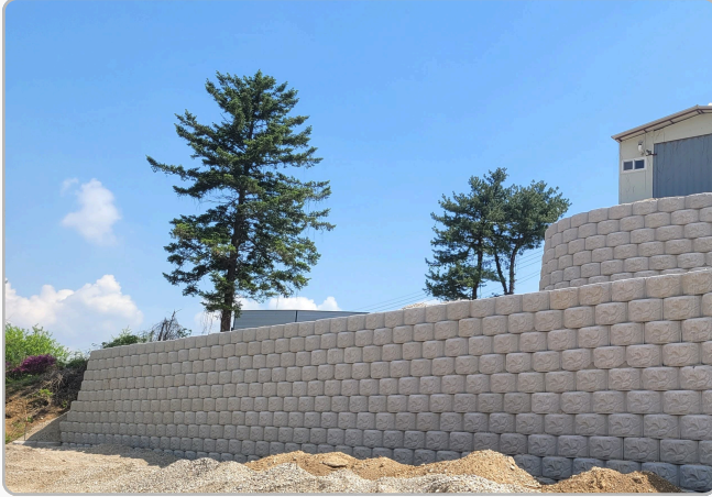
• 남양주 차산리 공장부지 조성공사
