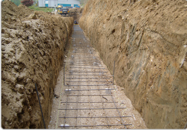
1. 기초 터파기 & 철근 배근
