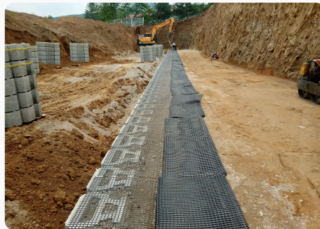
5. 다짐 및 그리드 설치
