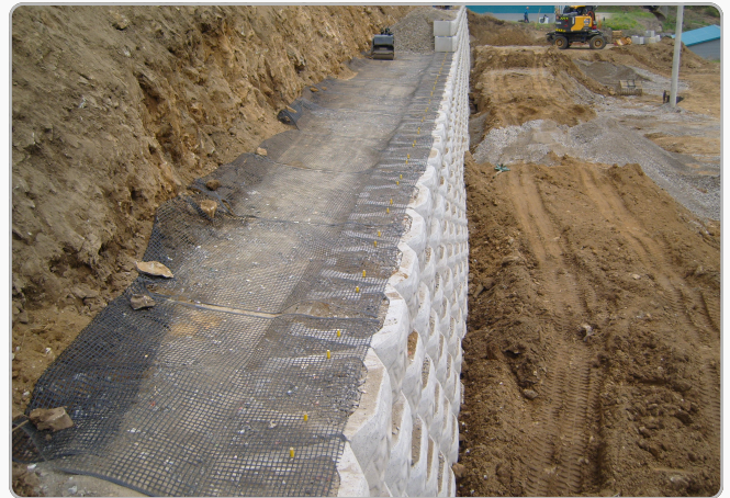
4. 뒷채움 골재 다짐 & 그리드 설치
