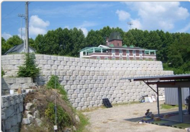
• 양평군 양평읍 회현리 축조공사
