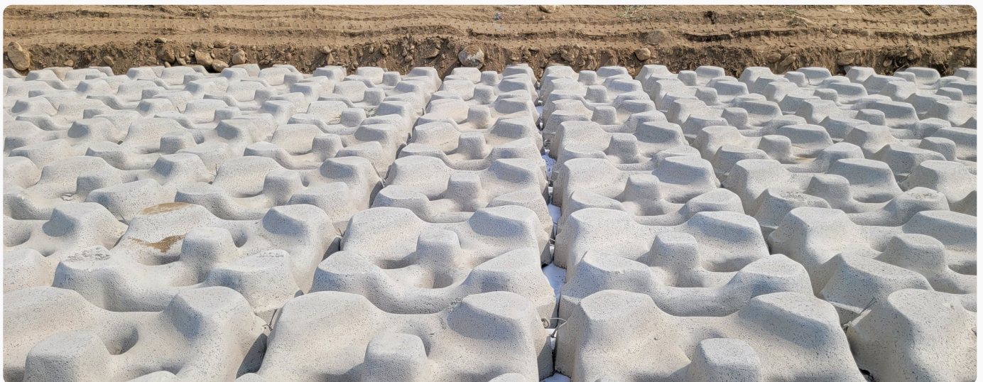
왕숙천 수해상습지 개선사업공사
